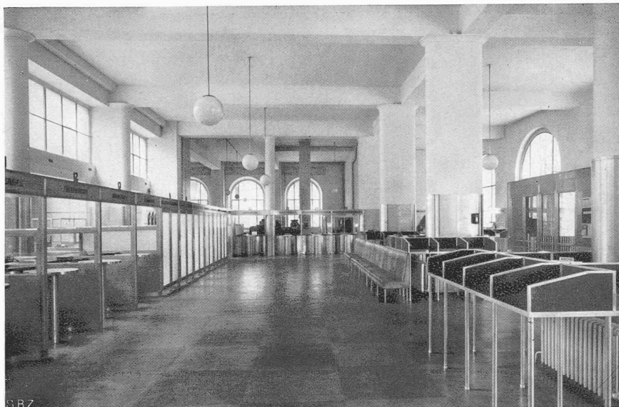
Abb. 17. Umbau 1934 der Schalterhalle Fraumünsterpost
