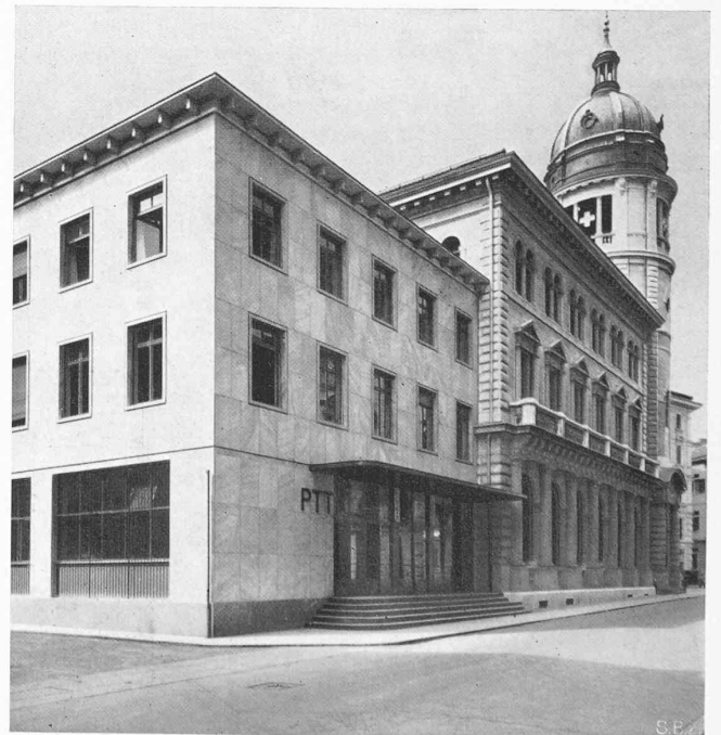
Abb. 8. Postgebäude Lugano, Links Erweiterungs-Anbau 1937
