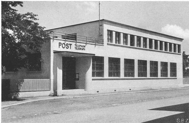
Abb. 30. Postgebäude Wallisellen, Strassenseite
