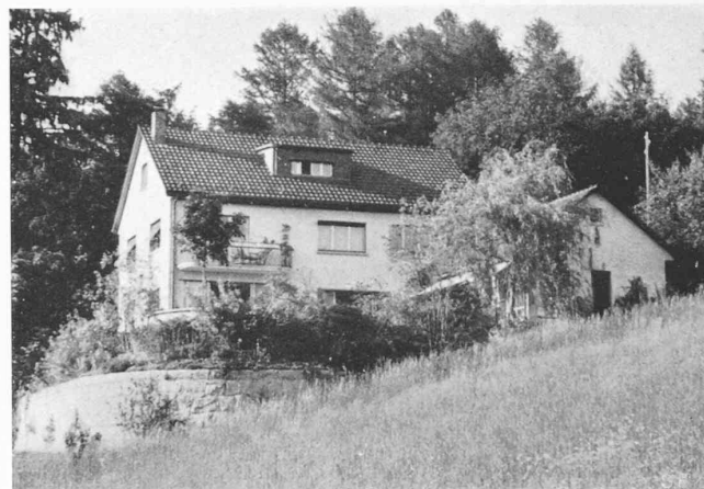
Abb. 15. Haus und Gartenterrasse aus Süden
