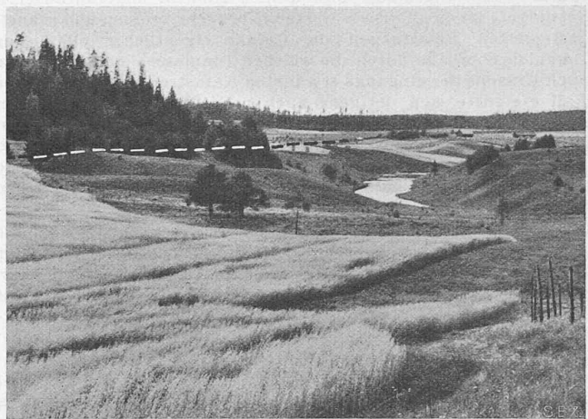
Abb. 5. Rutschgebiet bei Halikko; unbewaldet = Ton. Gestrichelt die durch Rutschung gefährdete, nach links verlegte Bahnlinie
