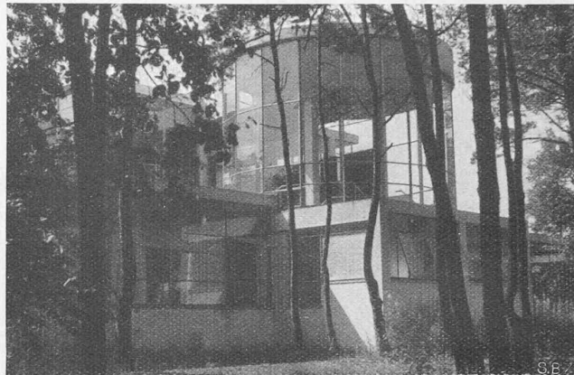
Abb. 10. Treppenhaus zum Essraum im Sanatorium Zonnestraal
