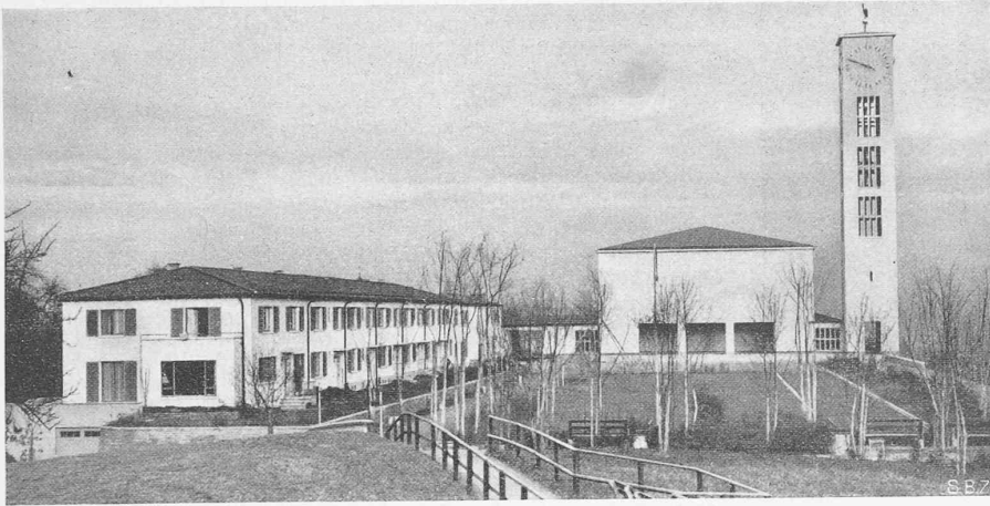
Abb. 3. Blick von Süden auf Wohnhäuser und Kirche mit Glockenturm
