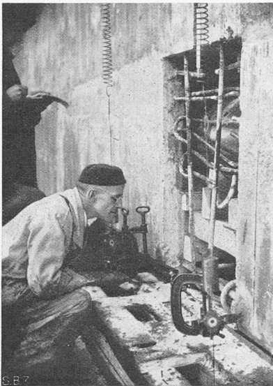
Abb. 3. Messung der vertikalen Bewegung im Scheitel durch Ing. A. Meyer, SBB
