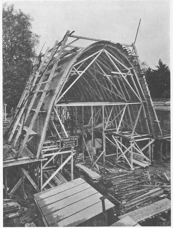
Abb. 42 Zementhalle [37], Armierung der beiden Rippen und der Schale, Lehr- und Arbeitsgerüste am 29. Oktober 1938
