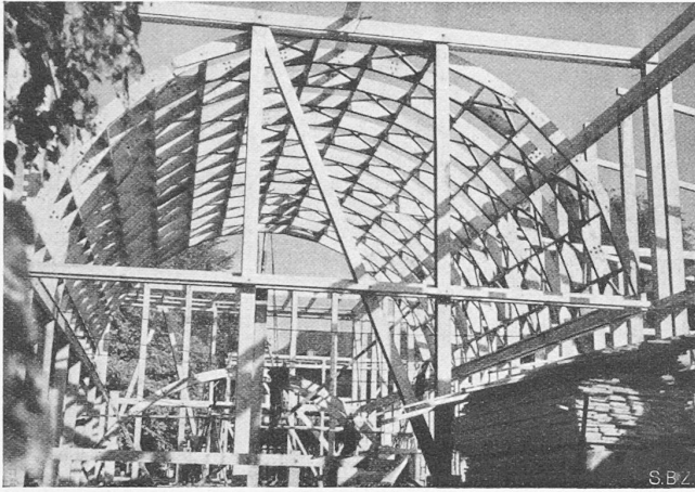
Abb. 20. Kinohalle [zu 45] beim Theater, Binderkonstruktion
