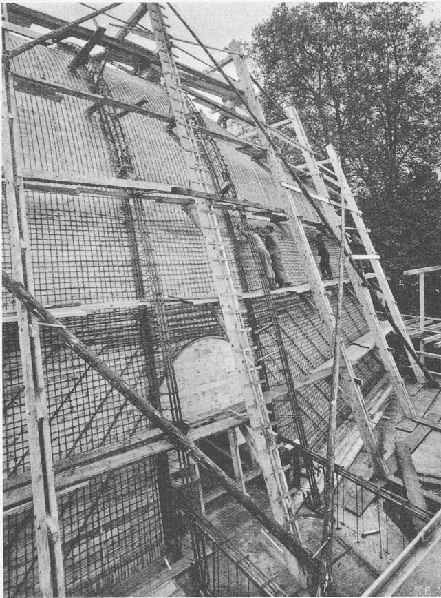
Abb. 42 Zementhalle [37], Armierung der beiden Rippen und der Schale, Lehr- und Arbeitsgerüste am 29. Oktober 1938
