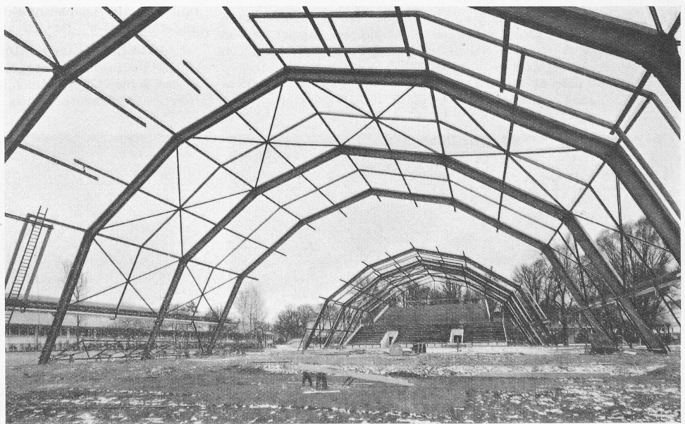
Abb. 54. Festhallen-Zeltdach [62] mit den längsverschieblichen zwei Mittelstücken, im Bau
