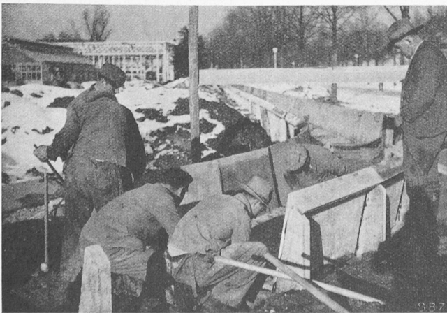
Abb. 33. Bau des Schifflibaches aus Eisenbeton-Elementen
