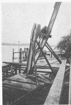
Abb. 51 und 52. Streben-Fundament des Schwebebahn-Turmes auf dem rechten Ufer
