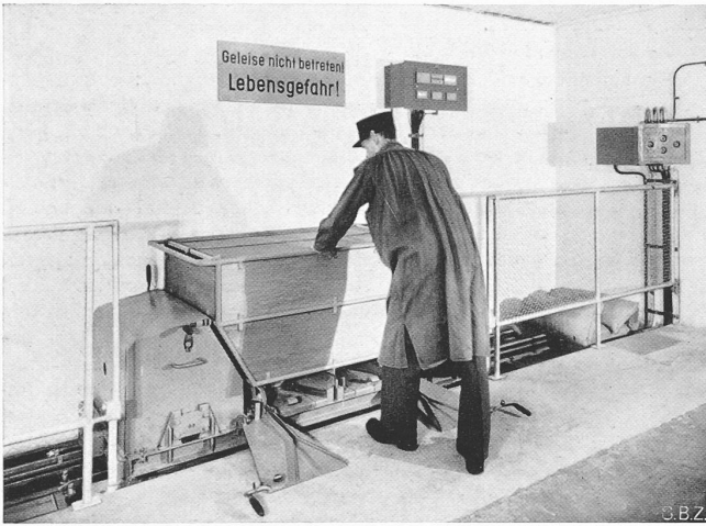
Abb. 5. Station Sihlpost. Die Ueberfahrbreiter sind heruntergeklappt, der Einsatzwagen wird seitlich herausgezogen. Rechts die Steuerungs-Druckknöpfe, an der Wand die Signaltafel
