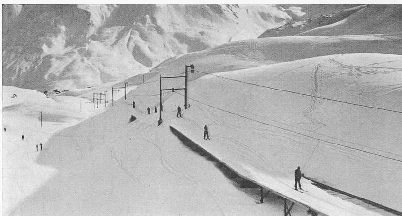
Abb. 2. Blick von der Weisshornhütte gegen Süden auf den obersten Teil der Anlage
