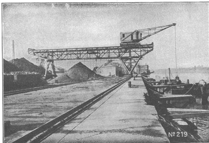
Verladeanlage im Hafen von Bilbao.
