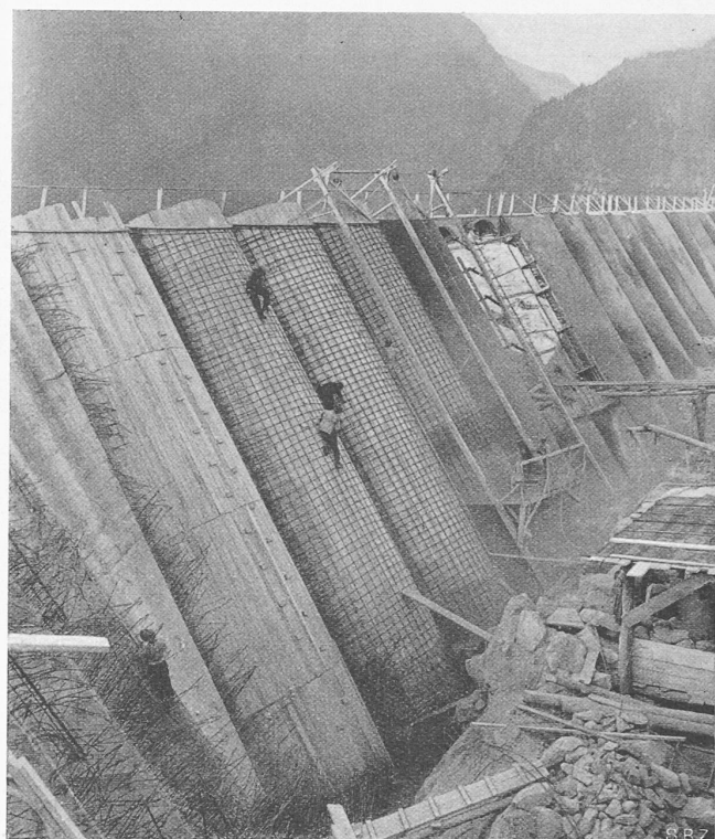
Fig. 14. Exécution des voûtes en gunite du barrage des Marécottes
