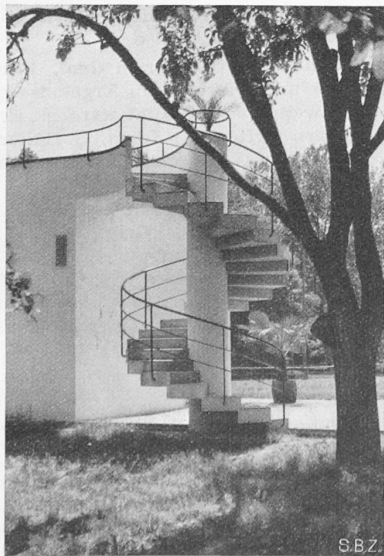
Abb. 17 bis 19. Anbau am Restaurant Kleinholz, Olten. — 1 : 400
