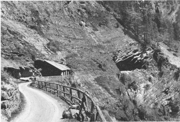
Abb. 3. Alpweg Vättis-Sardona, im Calfeisental; Galerie und Tunnel bei der Gigerwaldplatte
