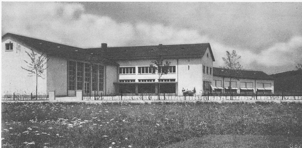
Abb. 2. Gesamtansicht der Schulhausanlage in Seuzach, aus Südosten
