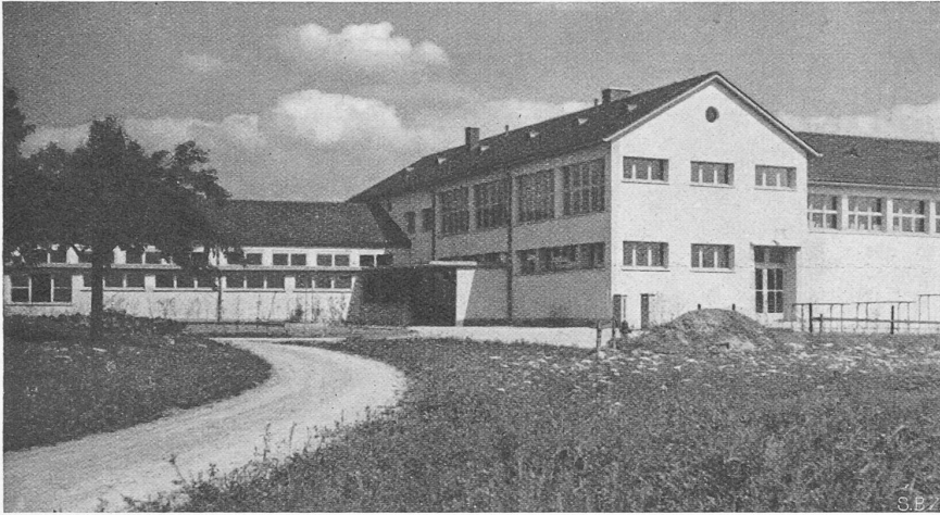
Abb. 3. Primarschulhaus in Seuzach bei Winterthur, Ansicht aus Nordwesten Architekten REINHART, NINCK & LANDOLT, Winterthur und Zürich Links der Klassenflügel mit den Gangfenstern, über denen die Lüftungsflügel der Klassenzimmer sichtbar sind; Mitteltrakt mit Schulküche und Handarbeitsraum im Obergeschoss, rechts Turnhalle
