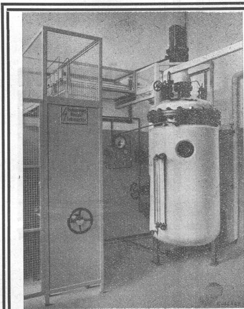
Elektrokessel für Wechselstrom 8000 V.
