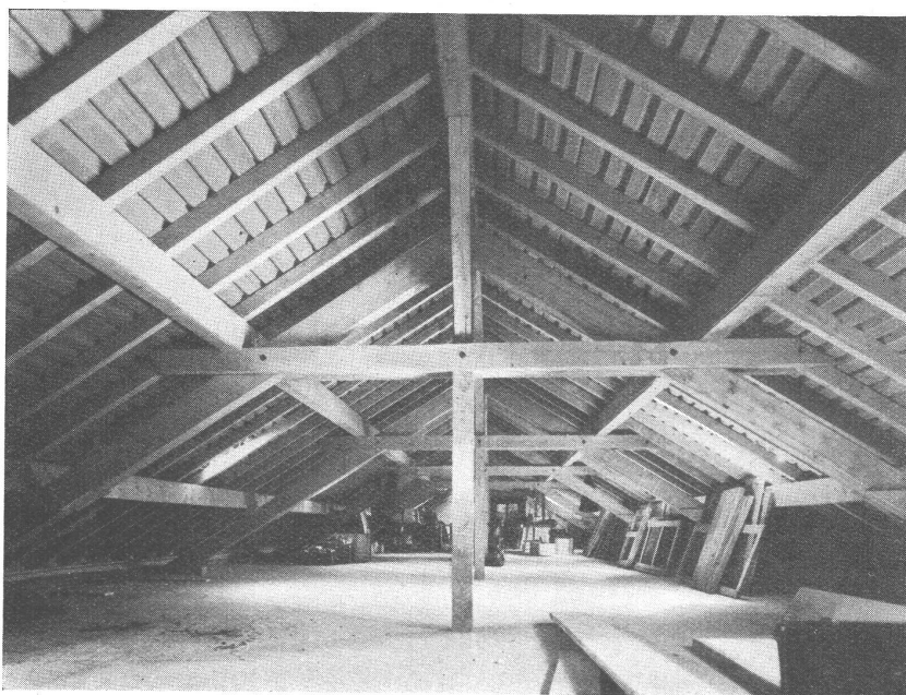
Fabrikgebäude in Heerbrugg.
