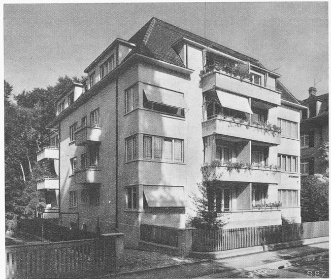
Abb. 1. Miethaus «Steinwies». Arch. H. NINCK, Winterthur-Zürich
