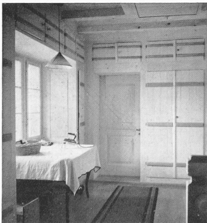
Abb. 14. Gang im I. Stock, Nordseite
