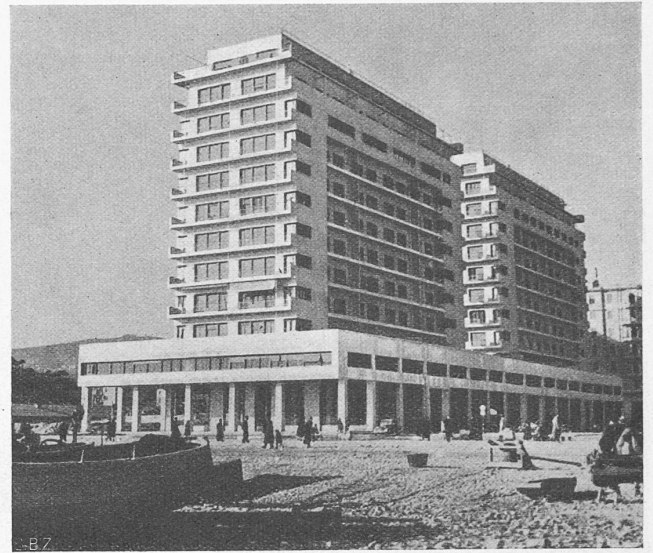
Abb. 10. Wohnhäuserblock, Piazza alla Foce, Genua. Arch. L. C. DANERI
