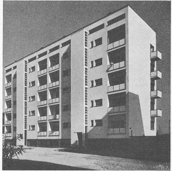
Abb. 12. Arbeiterwohnhaus in Mailand. Arch. F. ALBINI, R. CAMUS, G. PALANTI
