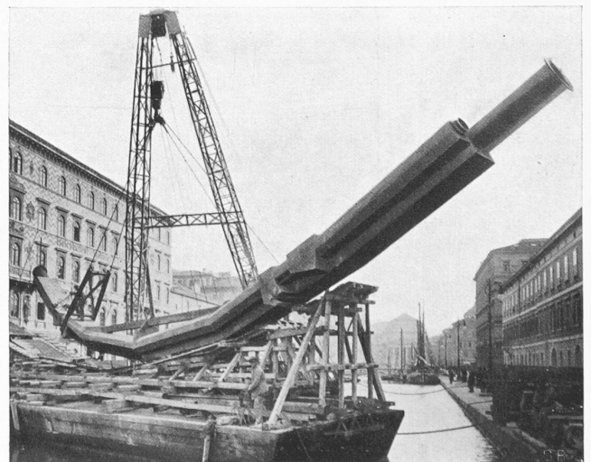
Abb. 2. Eisenbeton-Dücker von 40 t, fertig versetzt in eine Kanalsole Entwurf von Ing. LUDW. GSCHWEND, G. E. P. (von St. Gallen) in Triest
