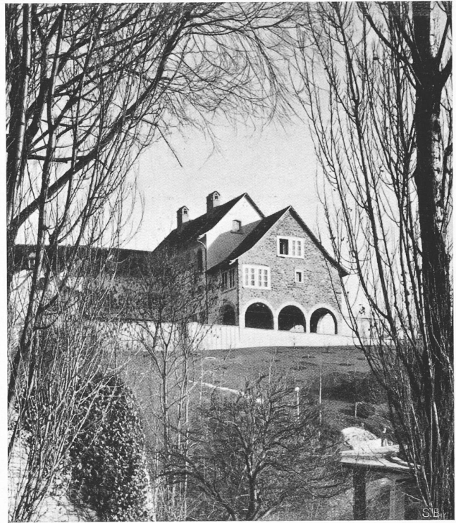
Abb. 2. Ansicht aus Westen, von der Zürichstrasse aus
