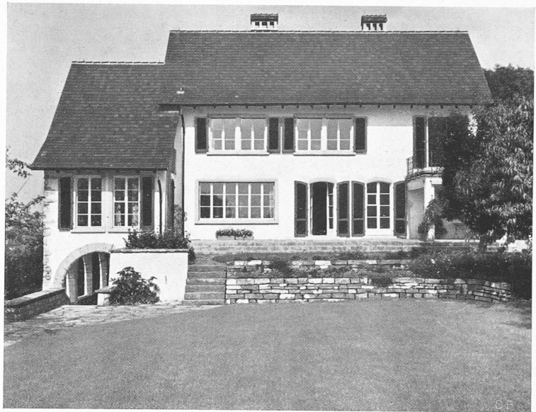
Abb. 13. Südfront des Hauses S.-v.H. in Küsnacht am Zürichsee
