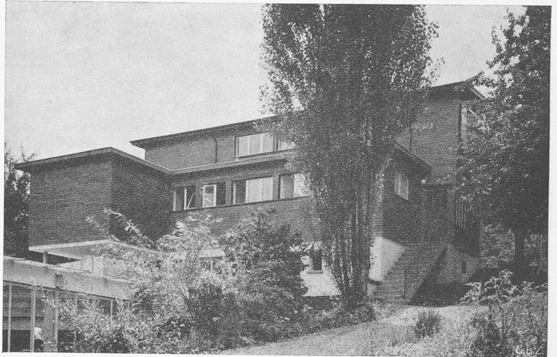
Abb. 3. Nordostseite der Kinderkrippe Lindt & Sprüngli, Kilchberg
