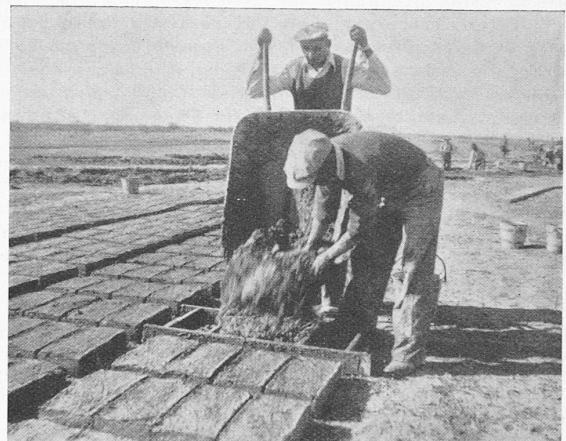
Abb. 18. Herstellung der «Adobe»-Ziegel
