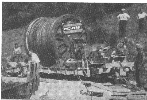
Transport der Trageiseilkabel für die Säntis-Schwebebahn
