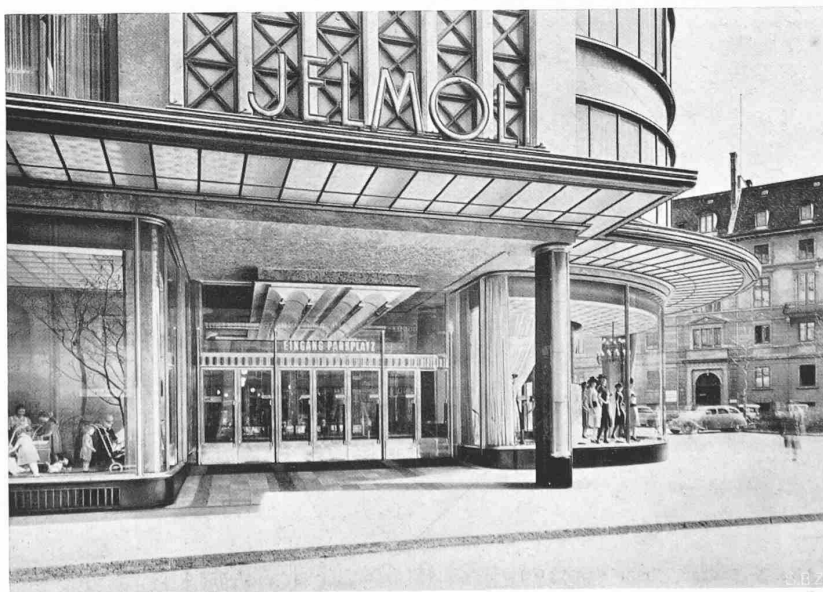
Abb. 4. Haupteingang Uraniastrasse, rechts der Steinmühleplatz
