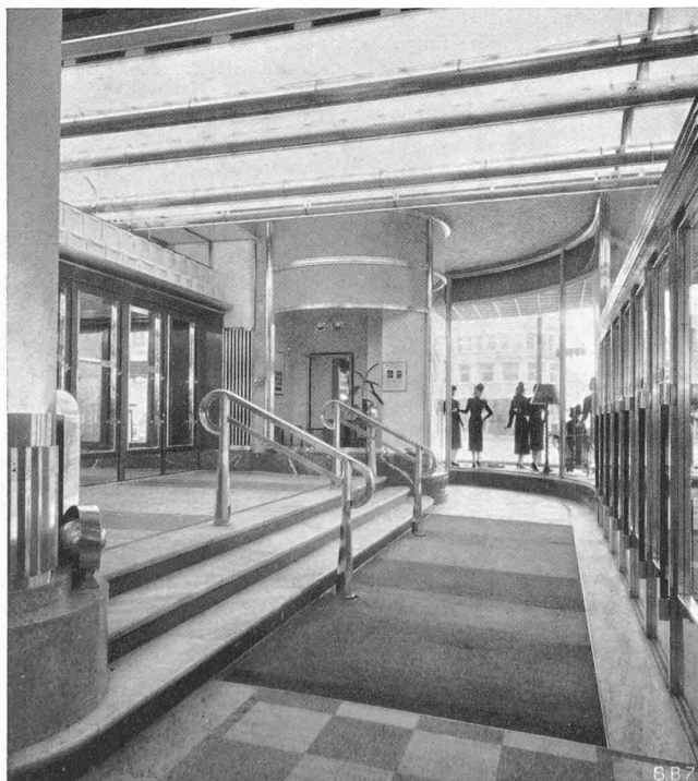
Abb. 5. Im Windfang des Haupteingangs Uraniastrasse
