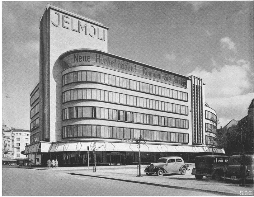
Abb. 2. Gesamtbild der westlichen Erweiterung am Steinmühleplatz
