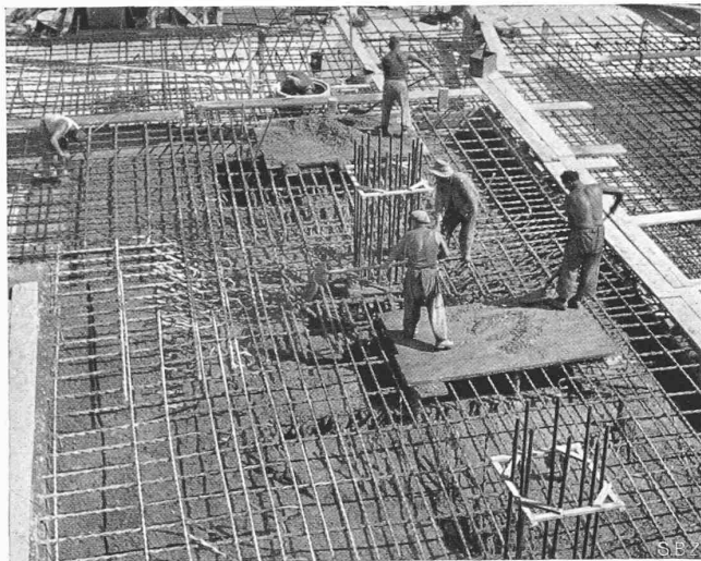
Abb. 17. Fundamentplatte mit Säulenansätzen
