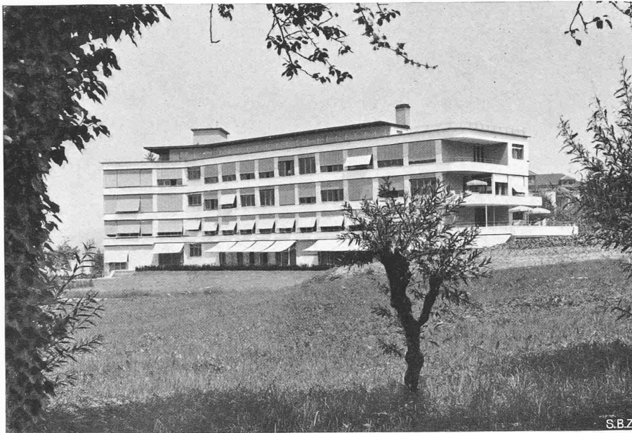
Abb. 1. Erweiterungsflügel des Bürgerspitals Zug, aus Süden gesehen
