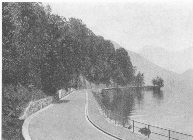
Abb. 10. Unbetonte, leichte Abschrankung der Strasse. Die Mauerstrahlen der Bergseite sollten humusiert und begrünt werden
