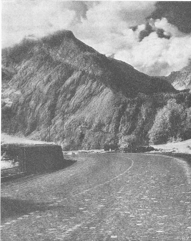
Abb. 8. Ideal eingebaute Alpenstrasse in Alpenlandschaft, ohne hässliche Begrenzung durch lebende Baumpfähle (Abb. 12!) und schwarz-weiss-Bretter an der Kurve. Bodenbelag (Steinpflasterung) naturverbunden
