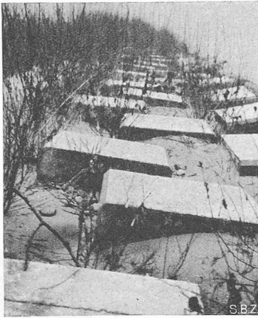
Abb. 8. Betonblöcke auf flachem Ufer, etwa zwei Jahre nach Ausführung
