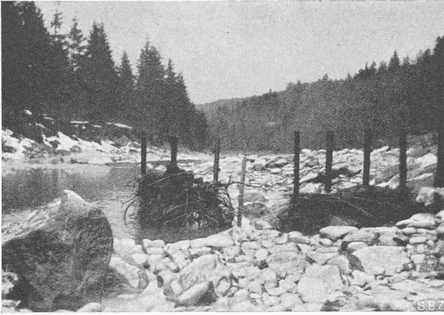
Abb. 16. Sporen aus eingerammten Eisenbahnschienen
