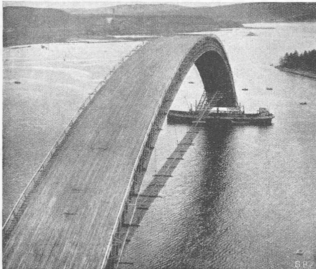
Abb. 7. Das Lehrgerüst der Sandöbrücke beim Einfahren
