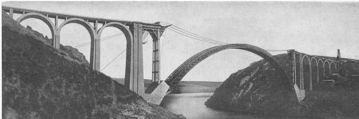
Abb. 10. Rio Esla-Eisenbahnbrücke in Spanien, 1936/1940. Lehrgerüst, Stützweite 210 m, Pfeilhöhe 62,4 m (im Bau)
