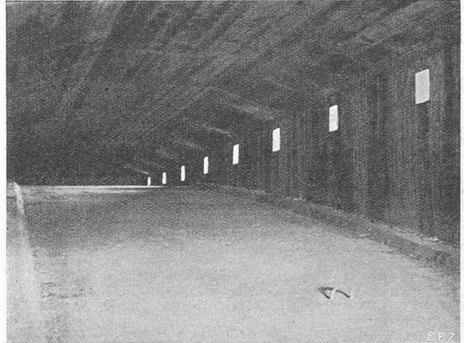
Abb. 34. Aeusserer Deckenteil des dreiteiligen Längsbaues über dem mittlern Gewölbeteil
