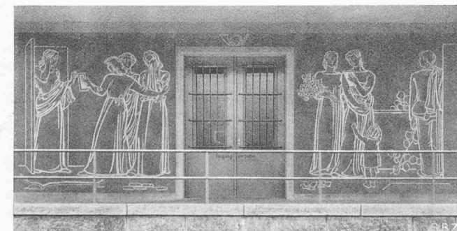
Abb. 9. Sgraffito von J. Gubler an der Stirnwand des Postpaketraums
