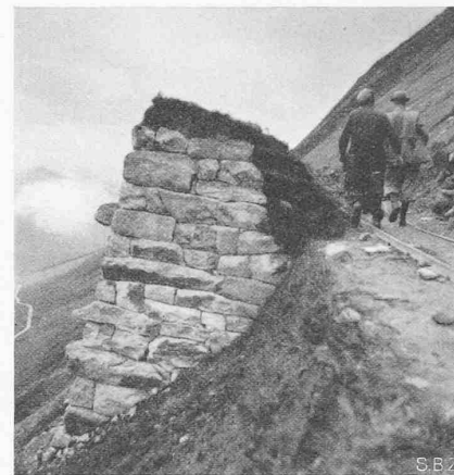
Abb. 1. Vorbildliche Trockenmauer als Lawinerverbauung an der Oberalp
