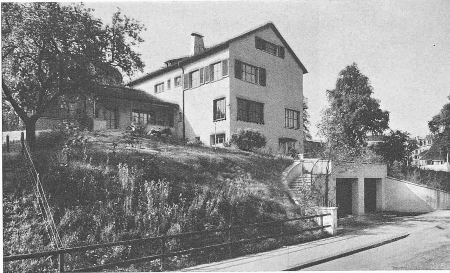
Abb. 4. Ein Arztthaus in Zürich-Wollishofen. Arch. HANS BAUR & SOHN, Zürich. Nord-Ansicht
