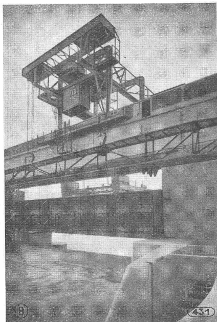
Stauwehranlage Klingnau, Ansicht von Oberwasserseite mit Dammbalkenkranen.
