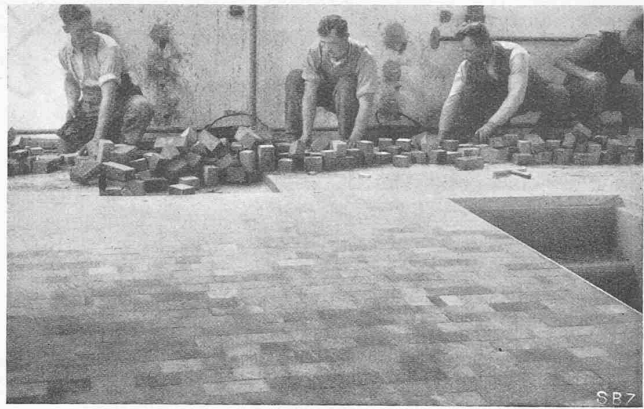
Abb. 5. Holzpfasterboden mit E-K imprägniert in Pressfugen auf Beton verlegt
