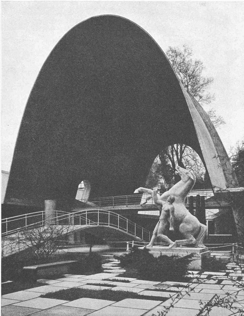
Abb. 1. Schifflibach-Brücklein, Betonplastik und Zementhalle in der LA 1939
