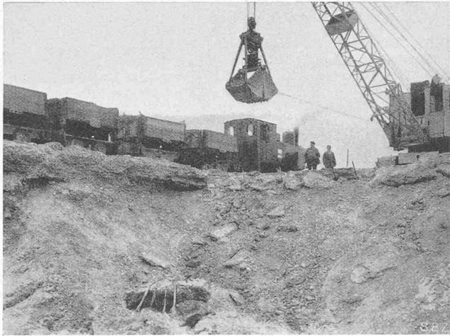
Abb. 8. Baggerung von gefrorenem und durch Sprengung gelockertem Kiesmaterial mit Raupen-Elektrobagger
