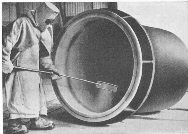
Abb. 3. Pudern eines Kessels mit hochsäurefestem Email
