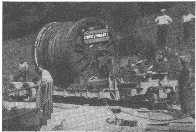
Transport der Tragseilkabel für die Säntis-Schwebebahn
