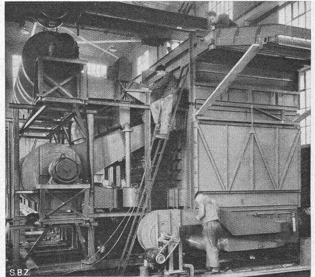
Abb. 2. Elektrischer Grastrockner BBC, von der Grasaufgabeseite Leistung 250 kg/h Trockengras, Anschlusswert total 650 kW
