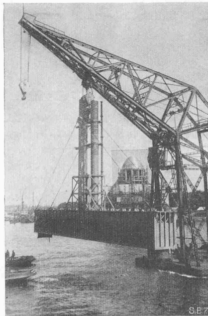
Abb. 23. Taucherglocke für die Ausführung der Tunneldecke in den Fugen
