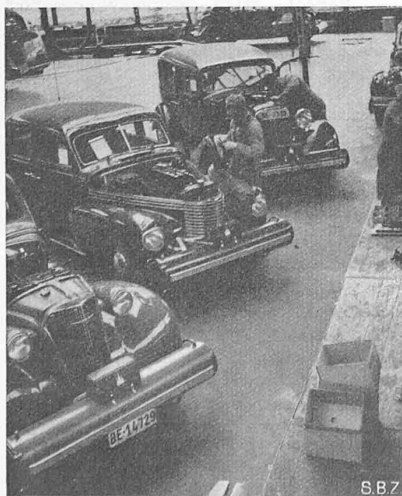
Abb. 9. Erstes Einregulieren der Motoren auf Azetylenbetrieb
