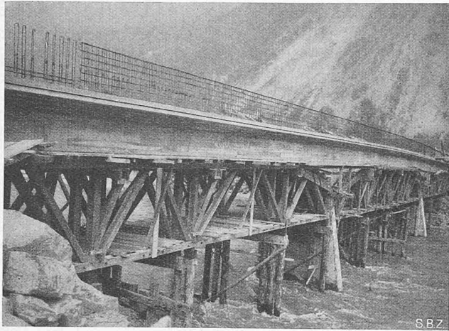
Abb. 4. Lehrgerüst, Brüstung armiert
