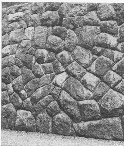
Abb. 8. Schlechte Zyklopenmauer aus braunem Numulitenkalk zusammengewürfelt
