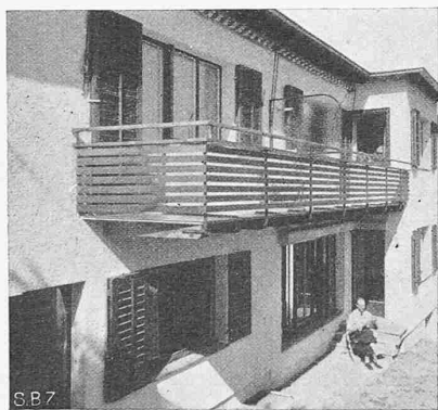
Abb. 4. Detail der Südfront
