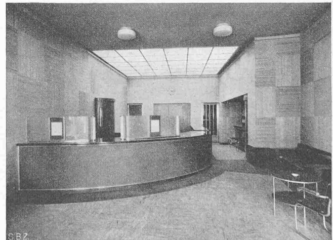
Abb. 5. Schalterraum, vom Eingang her gesehen
